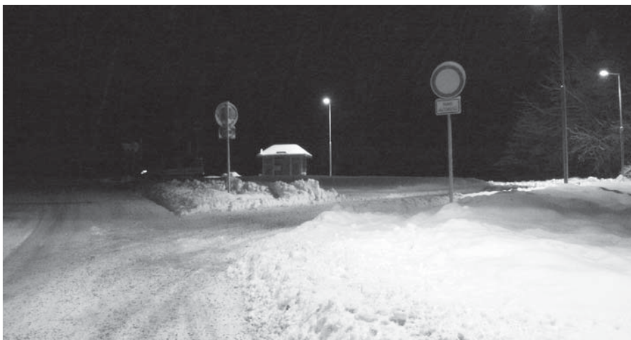
V letošním roce byla dokončena v horní části obce stavba "Točna autobusů Všemina", včetně postavení nové autobusové zastávky.
